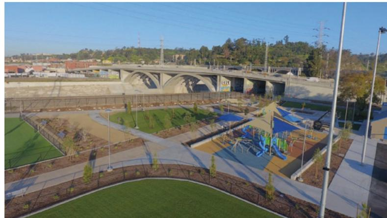
objectif a été atteint en détournant le volume d'eau – provenant du collecteur d'eaux pluviales situé sous la rue Albion et des eaux de ruissellement – vers les ouvrages destinés à l'amélioration de la qualité de l'eau qui ont été réalisés sur le site du projet. Les travaux ont permis de traiter et d'infiltrer les volumes d'eau détournés, ou de les utiliser pour les besoins du parc.
