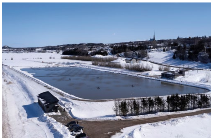
FIGURE 2 Vue de l'étang 1 avec bâtiment de l'Actiflo
