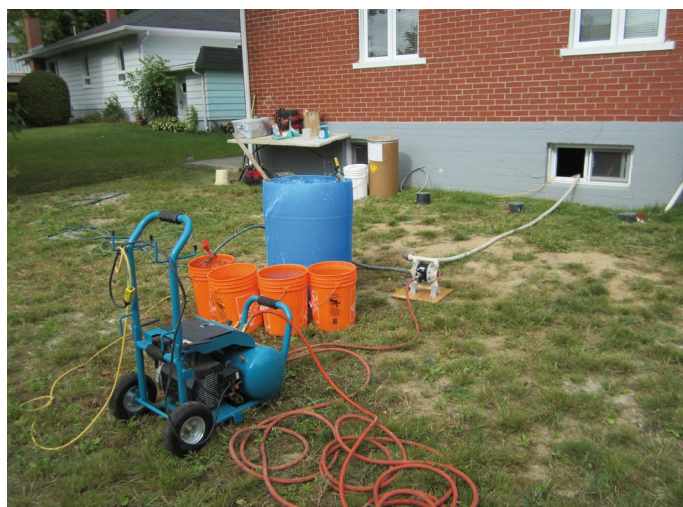
Installation du matériel d'injection.
