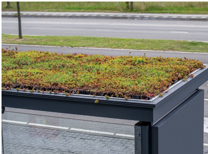
Toit vert d'un abribus permettant, entre autres, de diversifier la biodiversité.
