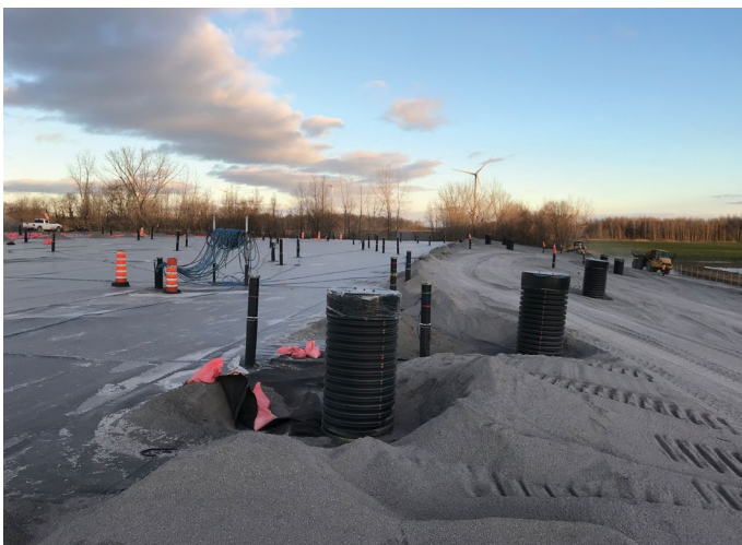
Construction du système de pompage et de couverture de la cellule de déchets.
